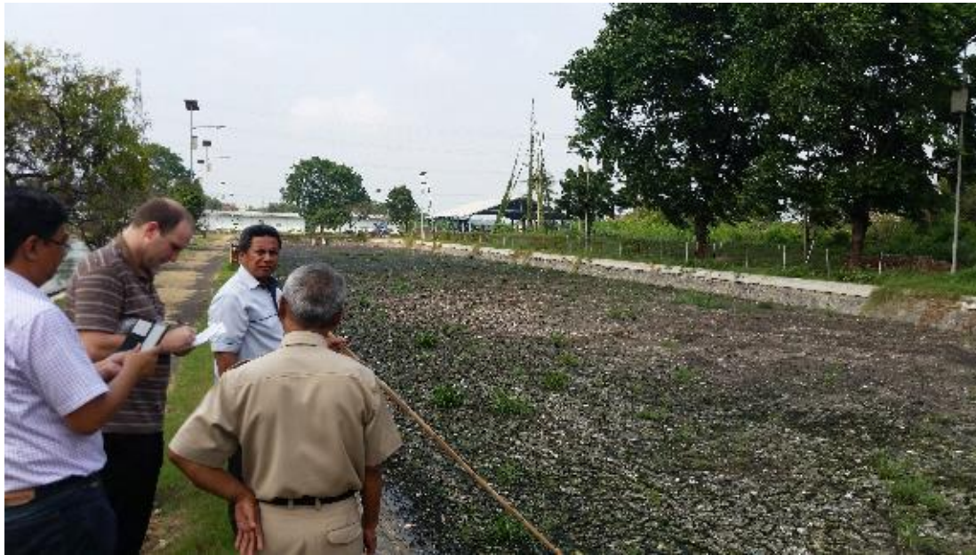
Aerobic Pond at Pulo Gebang
